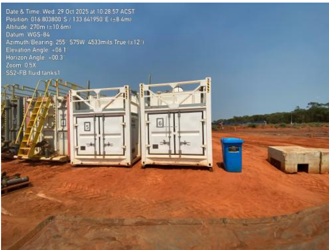
SS2-SGS FB fluid tanks1.JPG
