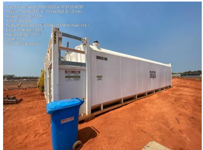
SS2-SGS FB fluid tanks2.JPG
